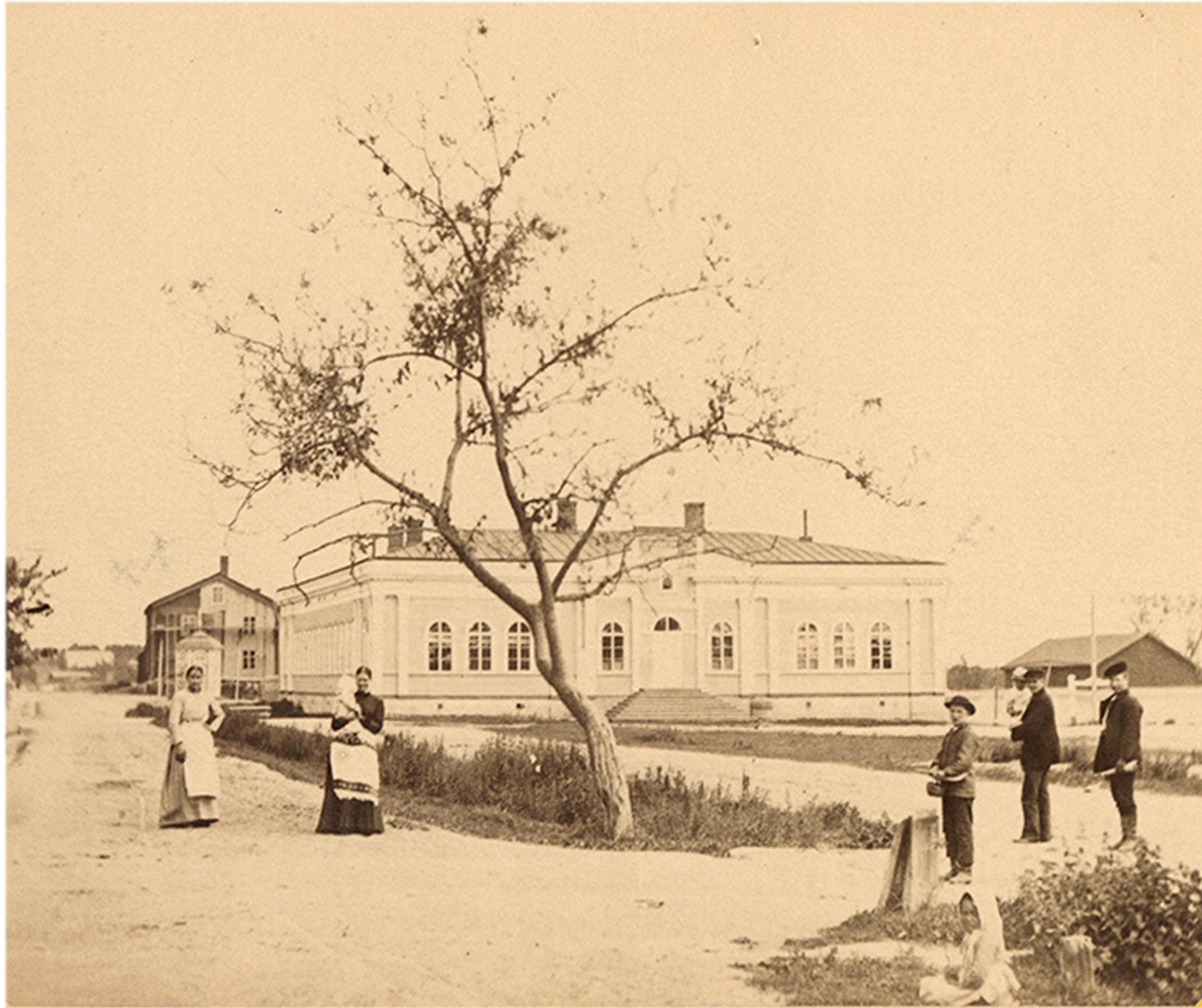
Vuonna 1866 valmistunut, arkkitehti L.I. Lindqvistin piirtämä yläalkeiskoulu Isokadun ja Tehtaankadun kulmauksessa. Koulu paloi 1990. Vi Neristassbor rf, Kokkolan kotiseutuarkisto.
