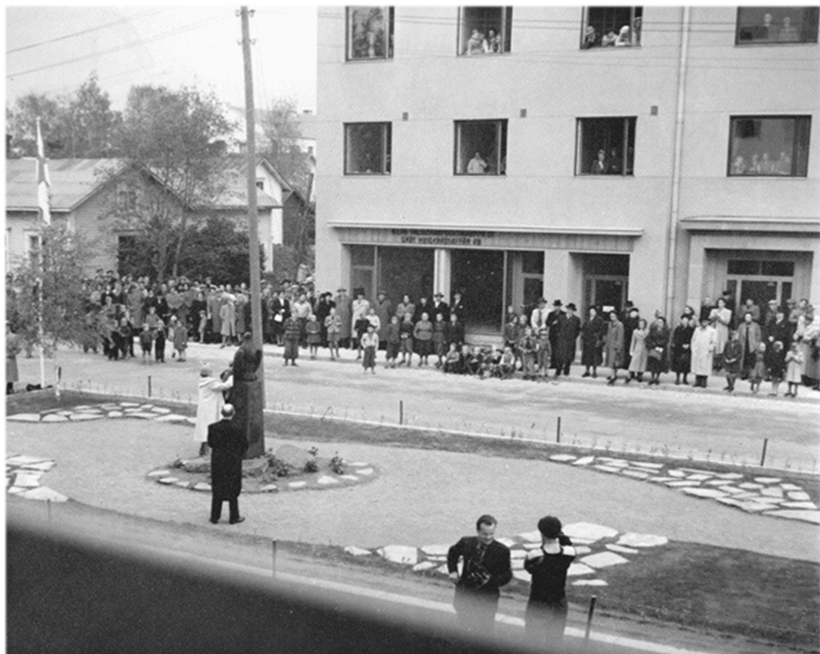
Heikki Huhtamäki lahjoitti Kokkolan kaupungille Pitkänsillankadun ja Kaarlelankadun kulmassa sijaitsevan Kokko-patsaan 1951. Patsaan jalustassa on kuvattuna Kokkolan pääelinkeinot. Patsas on kuvanveistäjä Essi Renwallin käsialaa. Vi Neristassbor rf, Kokkolan kotiseutuarkisto.
