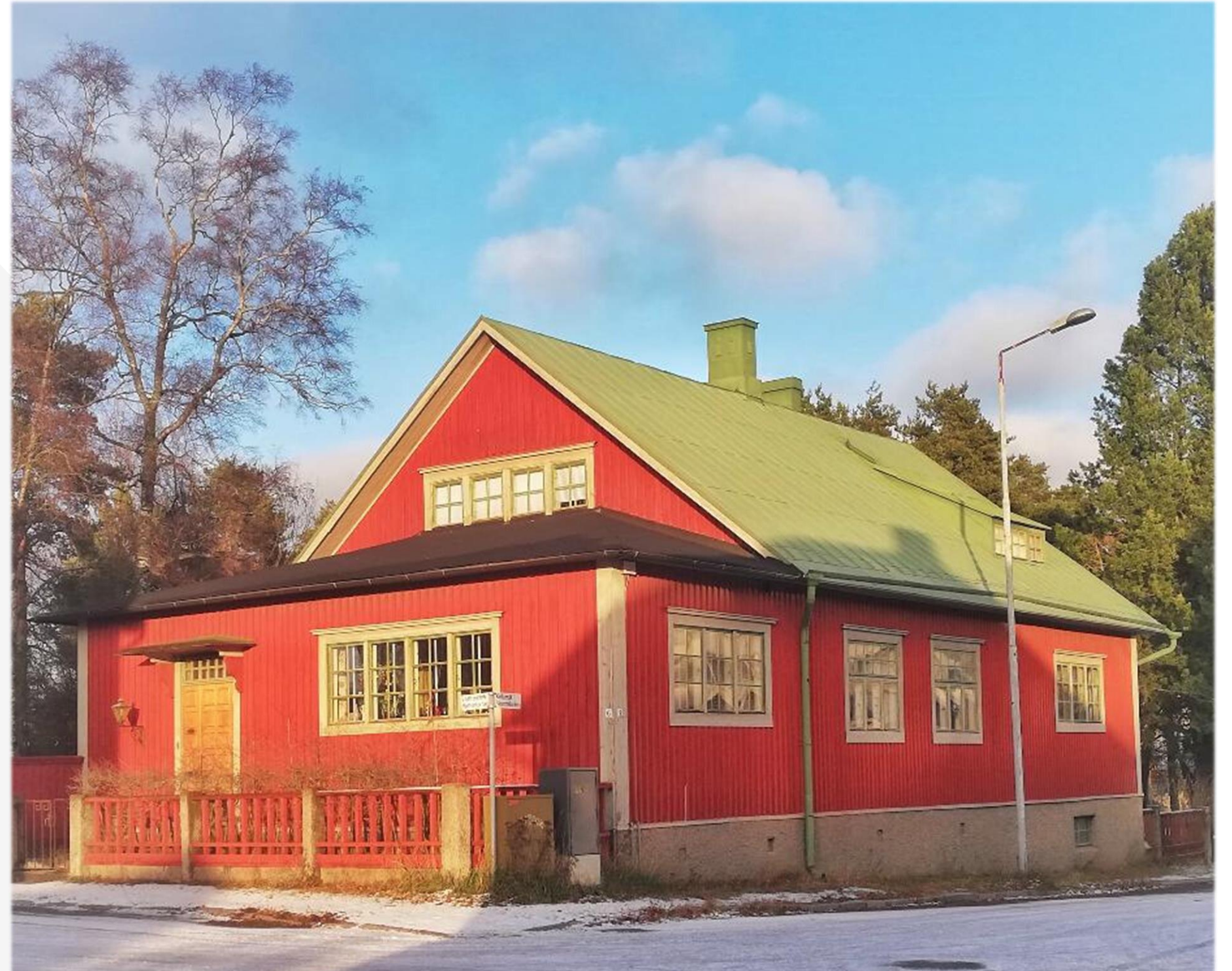
Knapes hus på Vattentornsgatan.
