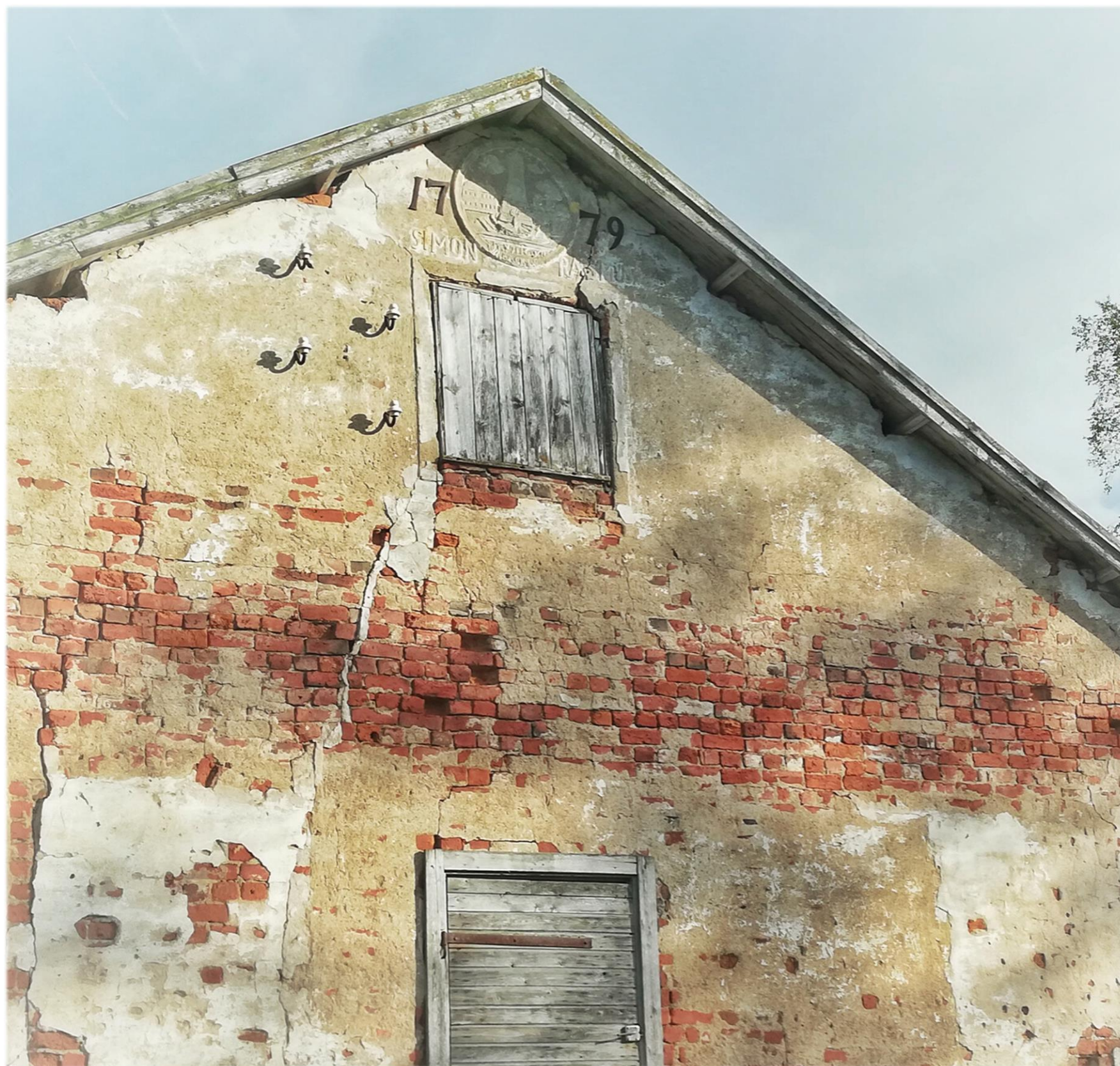
Simon Rasmuksen 1770-luvulla rakentama kivitalo muutettiin navetaksi 1912.
