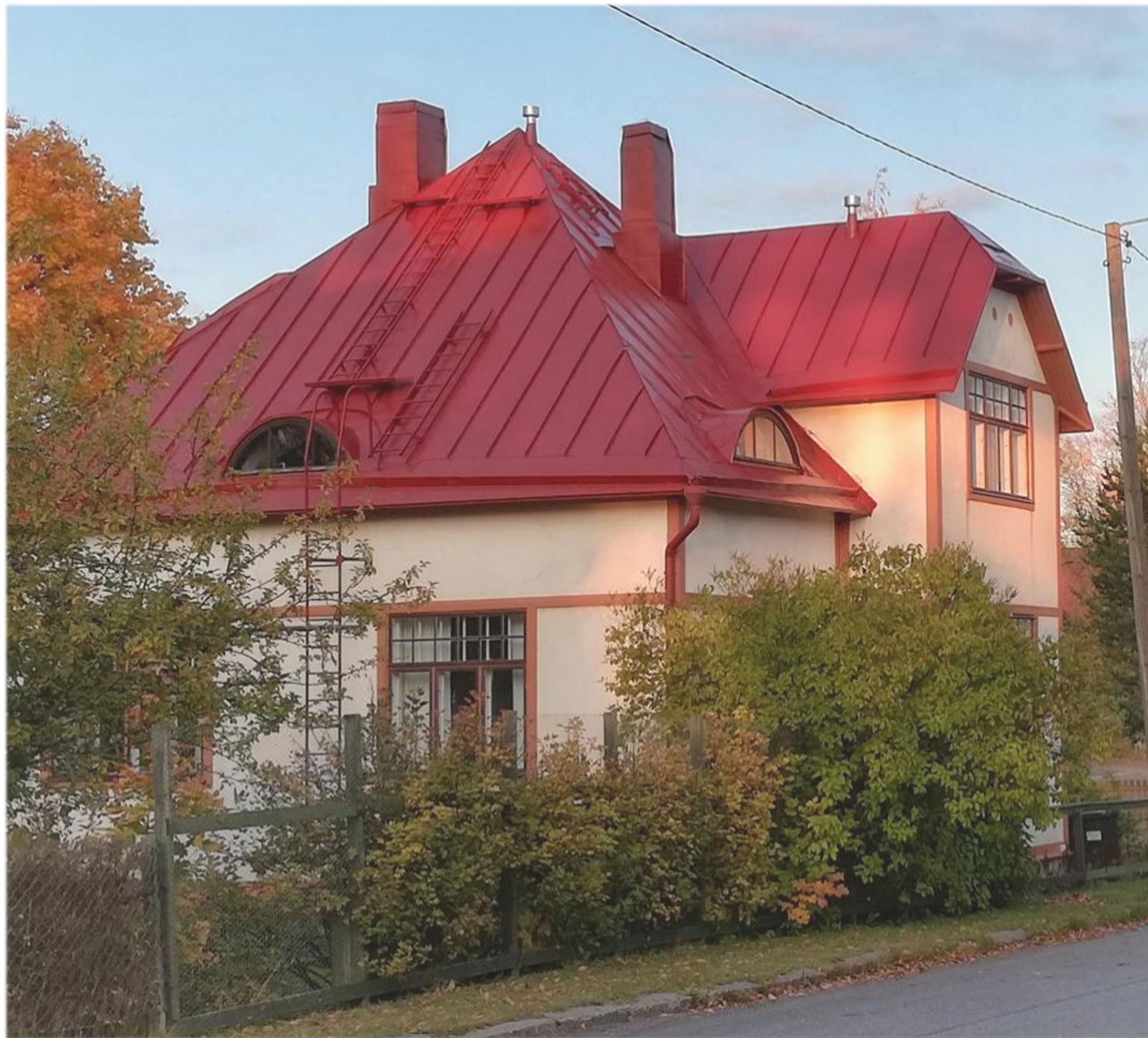
Åkermanin suunnittelema, Renlundin kansakoulun opettajan asunnoksi rakennettu talo. Opettajille rakennettiin saman piirustuksen mukaan kaksi taloa.
